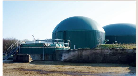
Die Biogasanlage mit einer Leistung von 191 kWel wurde 2010 in Betrieb genommen. Da alle Tiere im Betrieb auf Stroh gehalten werden, steht genügend Mist für die Beschickung der Biogasanlage zur Verfügung. Der Strom wird in das öffentliche Netz eingespeist, die Wärme für die benachbarte Grundschule und die eigenen Büro- und Sozialgebäude genutzt.
