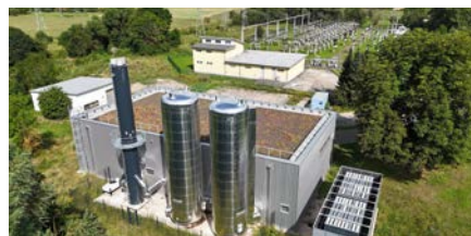
8 In 07552 Gera: Heizkraftwerk und Umspannwerk Auenstraße
