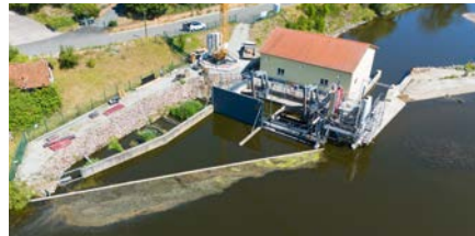
2 In 99826 Mihla: Wasserkraftwerk Auf dem Sand
