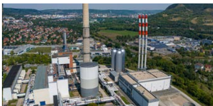
7 In 07745 Jena: Heizkraftwerk und Service Center Jena Rudolstädter Straße 41
