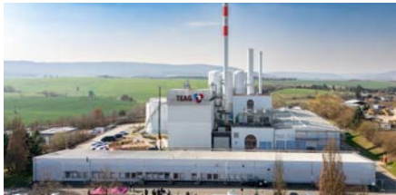
1 In 36433 Bad Salzungen: Heizkraftwerk Langenfelder Straße
