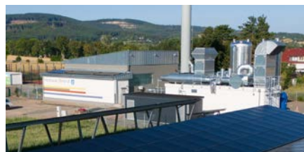
4 In 99885 Ohrdruf: Heizkraftwerk Südstraße
